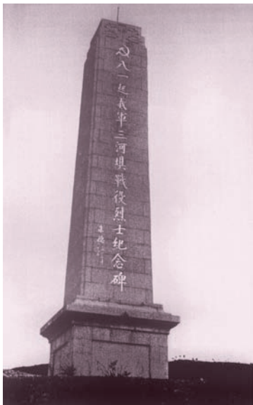
八一起义军三河坝战役烈士纪念碑，1963年广东省大埔县兴建、朱德题写碑名，三河坝战役时任第二十五师师长的周士第撰写碑文
