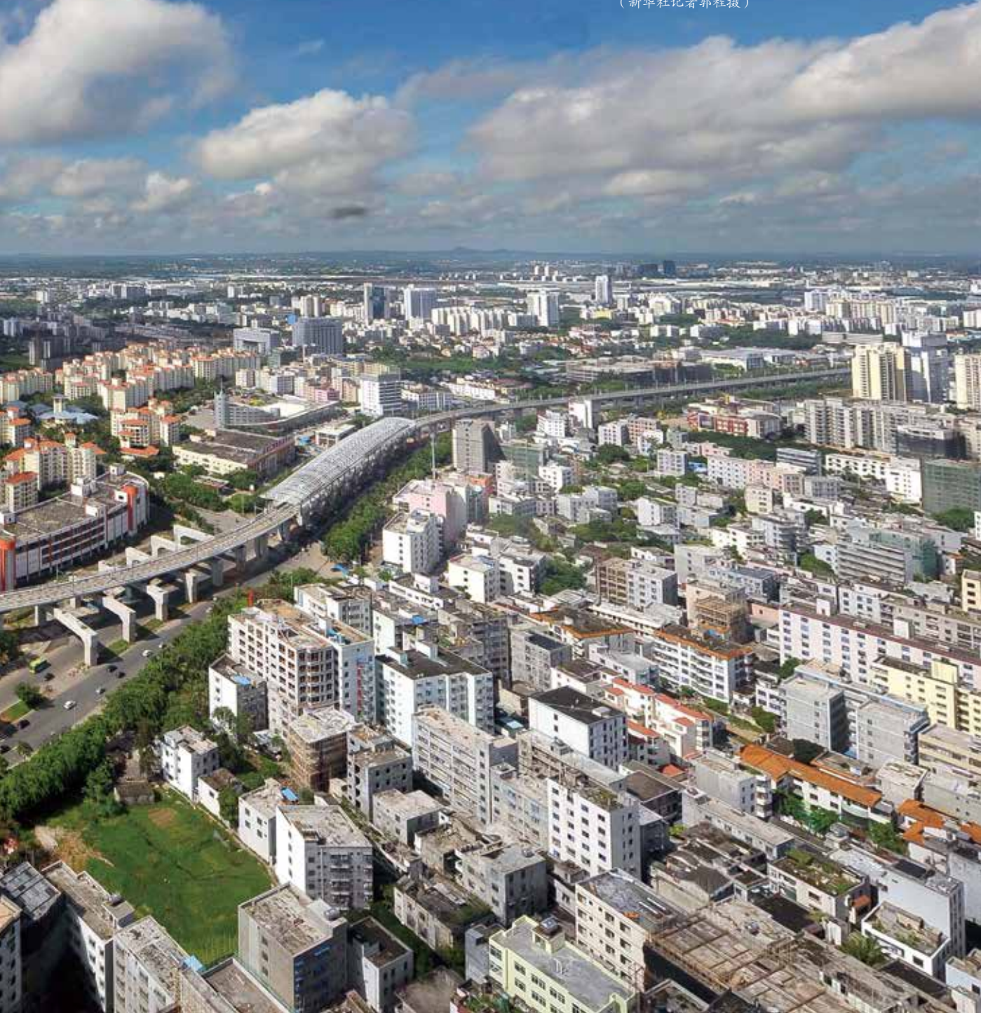
2010年8月13日，建设中的海南东环铁路海口段。 (新华社记者郭程摄)
