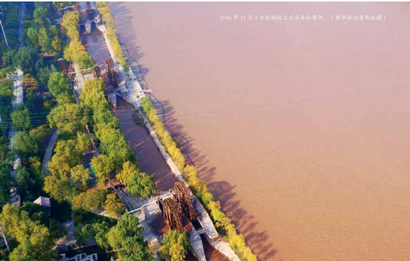
2015年8月20日，兰州市水源地建设项目控制性工程——输水隧洞工程在甘肃永靖县开工，标志着项目进入实际施工阶段。图为兰州市水源地工程取水水源——刘家峡水库库区。兰州市水源地建设项目以刘家峡水库为饮水水源地，向兰州市区供水。（新华社记者范培坤摄）
