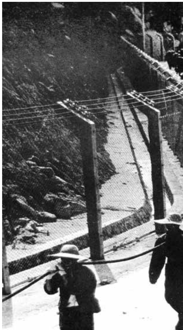
▲ 广东边防总队官兵铺设深圳经济特区管理线电缆。（资料照片）
