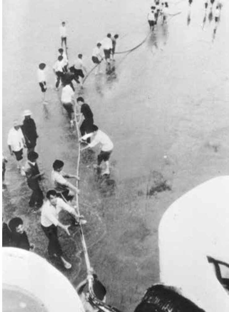
▲ 1993年12月15日，中国的第一条海底光缆——从上海南至日本九州宫崎、全长1252公里的中日海底光缆正式开通。这条海底光缆系统通信总容量达7560条通话电路，相当于建于1976年的中日海底同轴电缆的15倍以上。中日海底光缆的开通，使中国国际通信能力增长80%以上。
