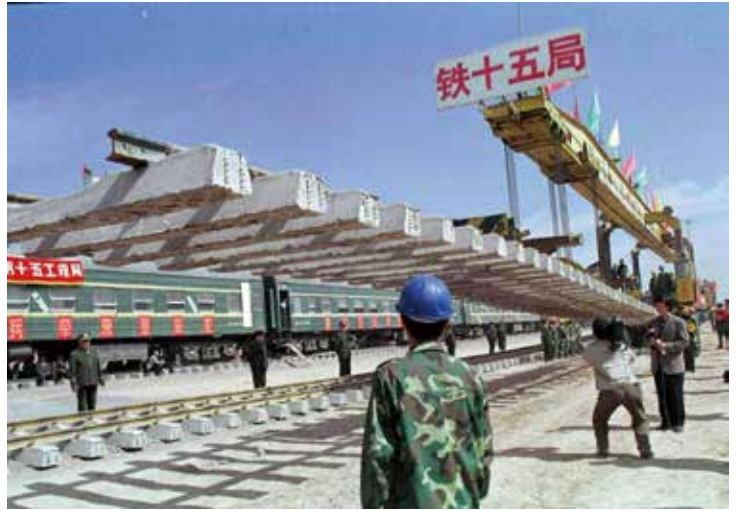
▲ 1999年5月6日，南疆铁路西段铺轨抵达终点喀什站，至此，南疆铁路全线铺通。南疆铁路东起吐鲁番，西至喀什市，全长1446公里。此次修建铺通的是1996年9月从库尔勒西站引出的西段。图为即将落地的最后一节轨排。（新华社记者罗晓光摄）
