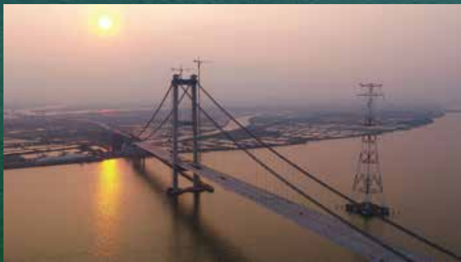
▲ 2018年5月23日，坭洲水道桥。2018年5月25日，广东省交通集团通报，“粤港澳大湾区”重要交通基础设施项目虎门二桥取得重大建设进展。作为虎门二桥的一座主桥，跨径1688米的坭洲水道桥顺利合龙。（新华社发）
