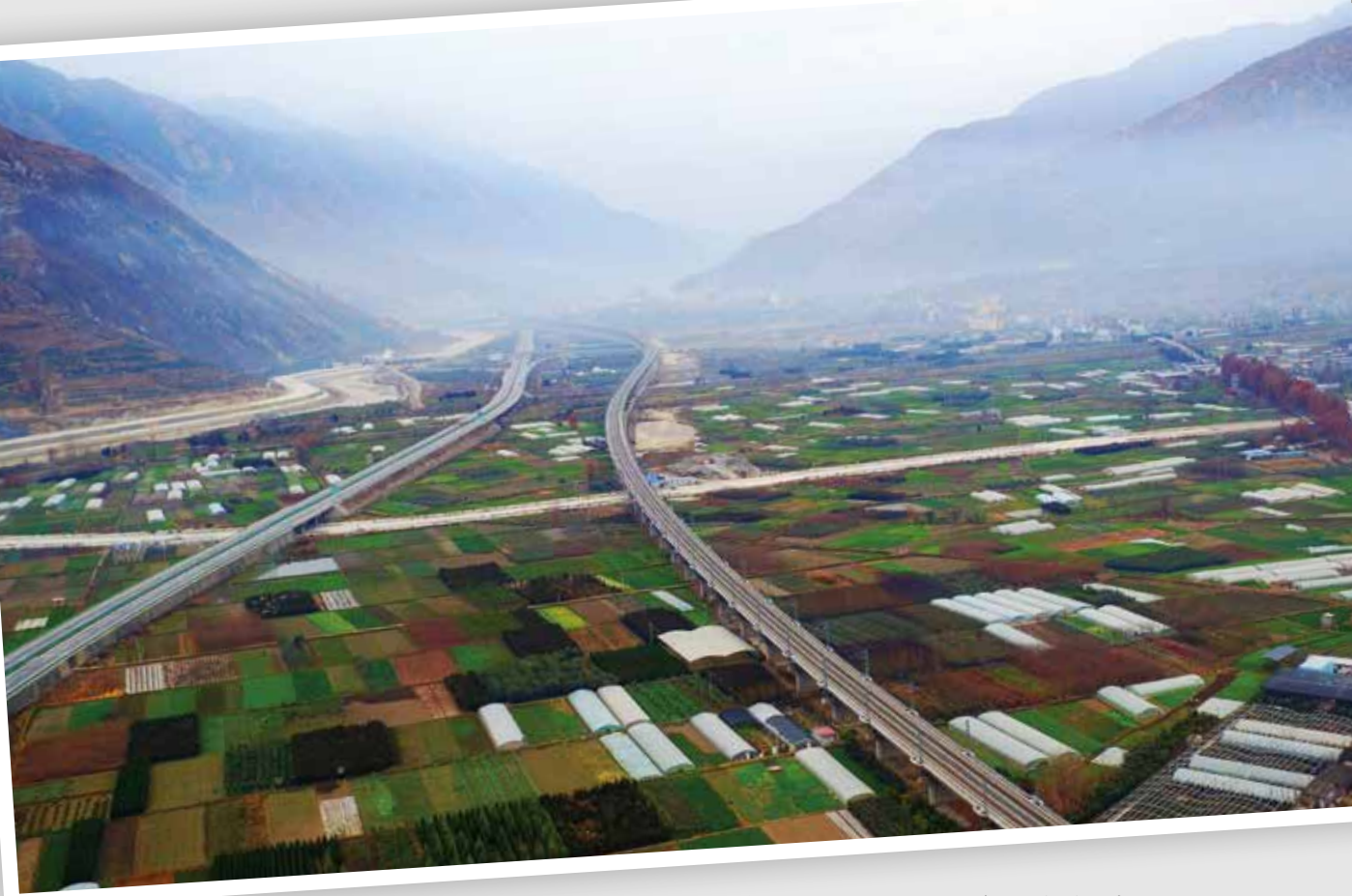
▲ 2016年12月25日，兰渝铁路陇南境内白龙江3号特大桥（右）与高速公路从山脚下蜿蜒伸出。（新华社记者陈斌摄）
