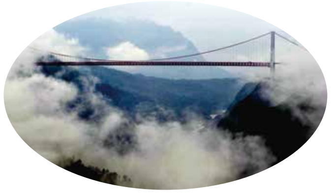
▲ 2010年7月23日，位于贵州安顺的坝陵河大桥。2009年12月23日，地处贵州省关岭县与国家级风景名胜区黄果树瀑布交界处的坝陵河大桥正式通车。坝陵河大桥全长2237米，主跨1088米，距河面垂直高度370米。该桥的建成不仅极大方便了两岸群众，更实现了贵州与云南两省高速公路快速连接。（新华社记者杨楹摄）
