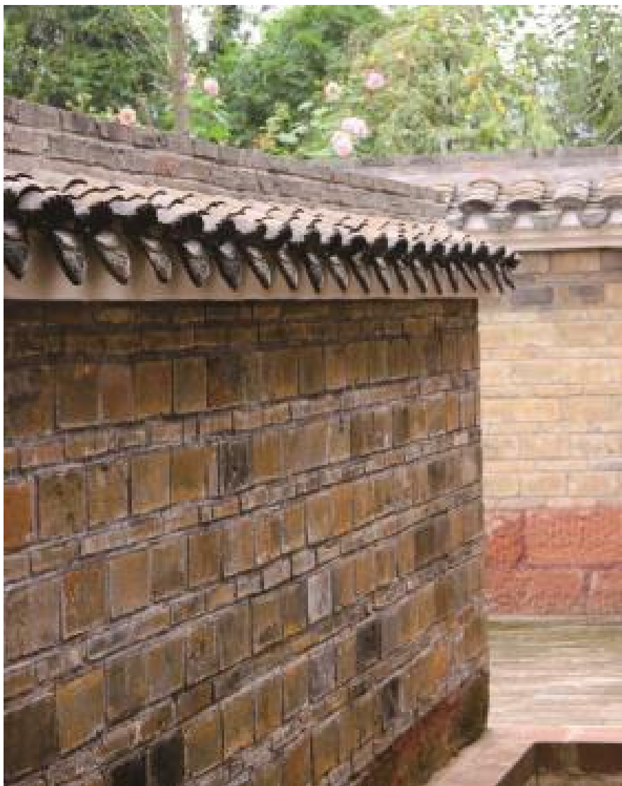
上空斗下石料墙
