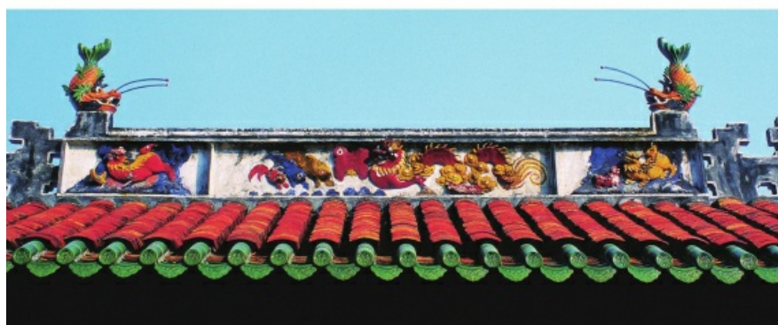
广东东莞南社村祠堂屋顶
