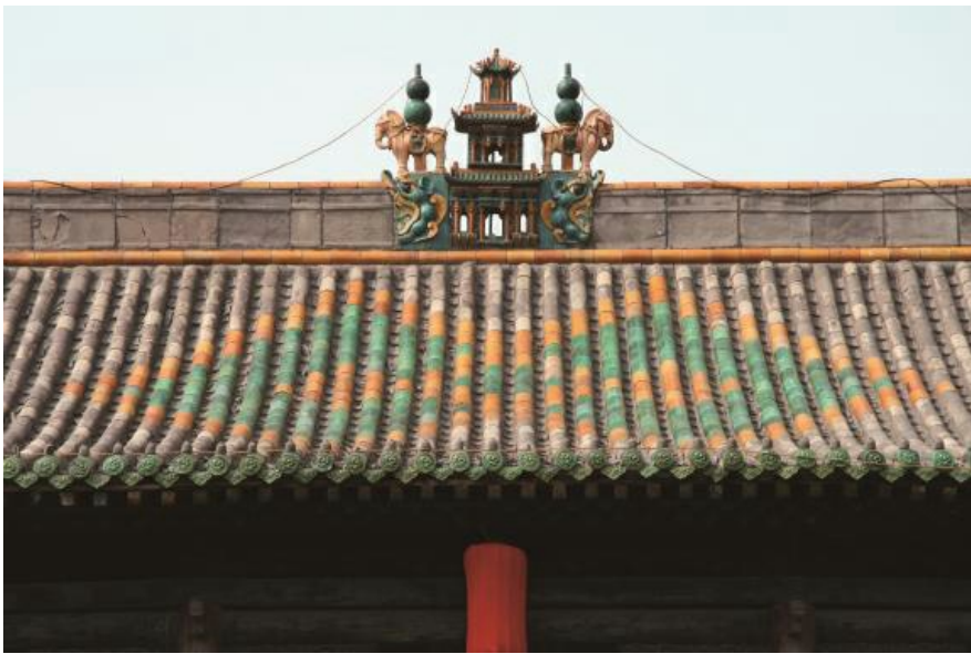
平遥城隍庙侧殿屋顶
