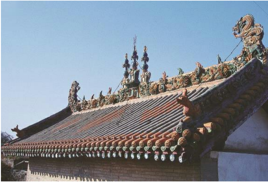
张壁村西方圣境殿屋顶正脊
