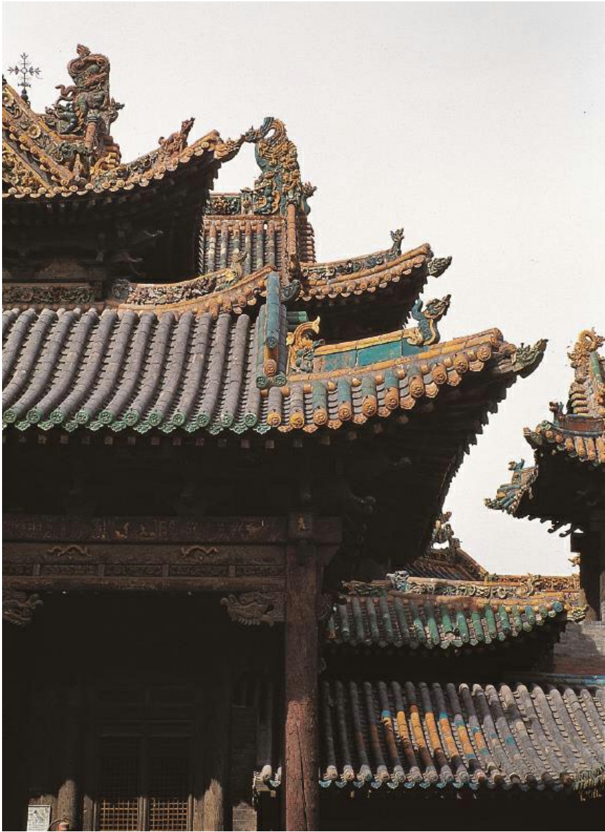
山西介休后土庙殿堂屋顶
