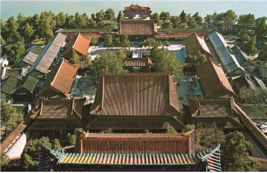
颐和园排云殿屋顶
