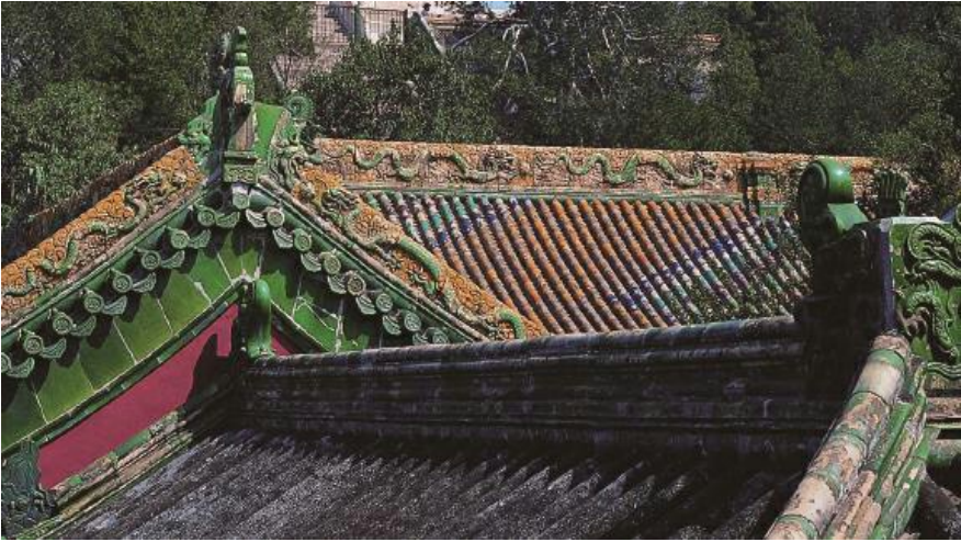
北京北海永安寺大殿屋顶
