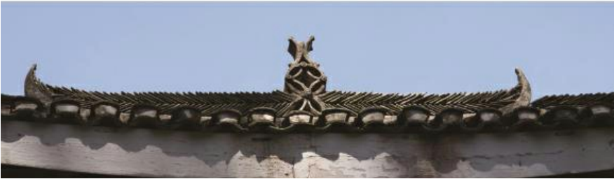
各地建筑屋顶瓦作正脊
