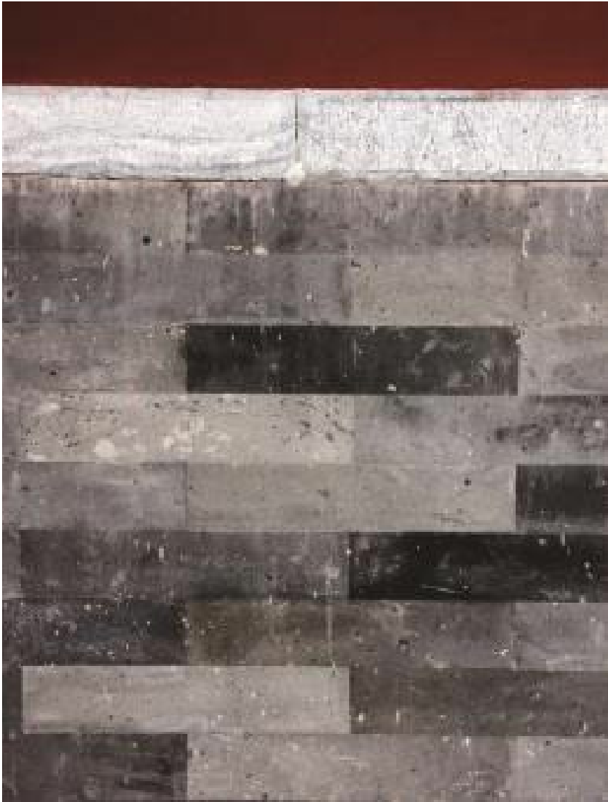
北京宫殿磨砖对缝墙
