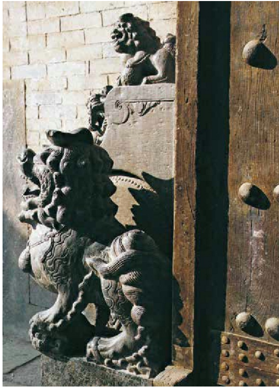
山西农村住宅门枕石与夹杆石并列的大门实景2
