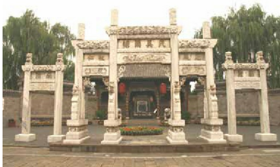
山西榆次寺庙前石牌楼
