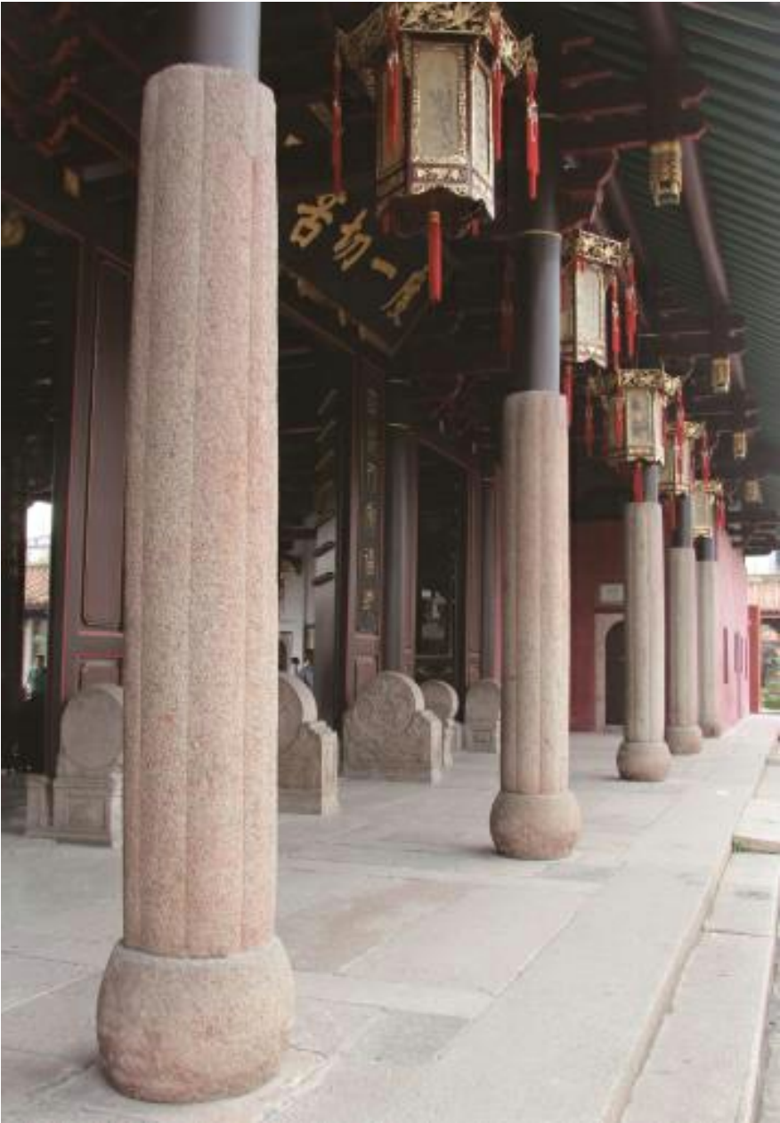
广东潮州开元寺木石混合石柱
