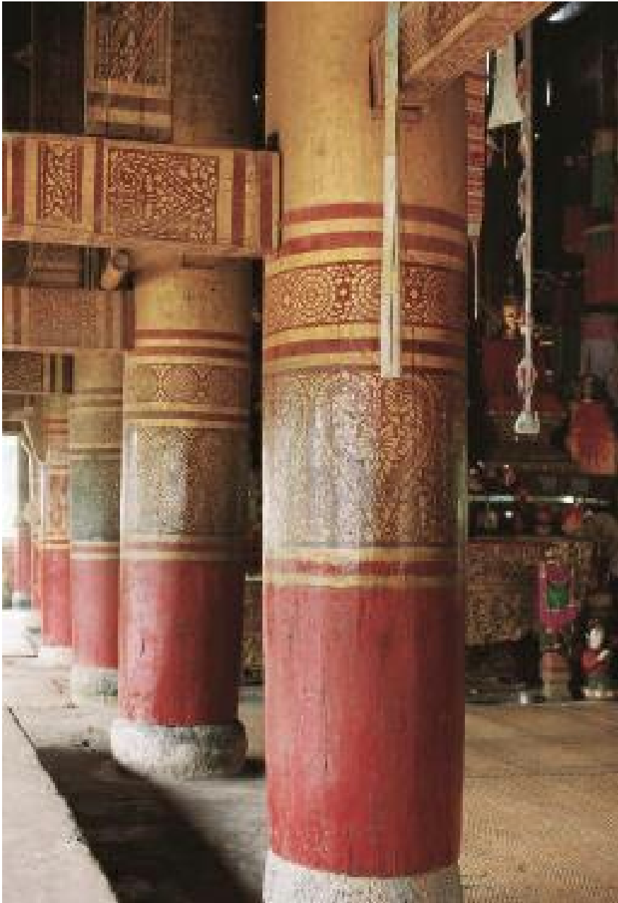
云南西双版纳佛寺大殿立柱
