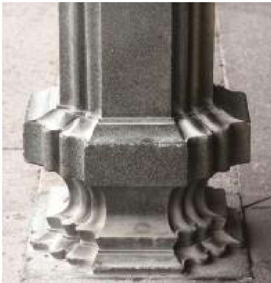
门厅外檐石柱柱础
