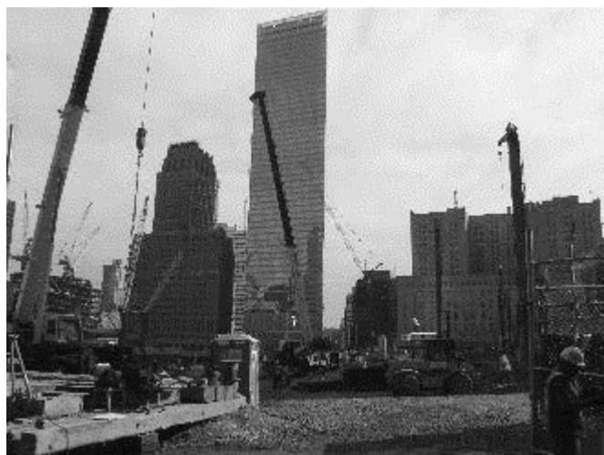
世贸中心工地现场
