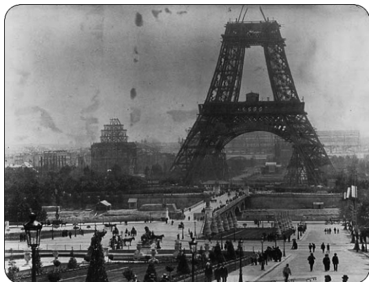
兴建中的埃菲尔铁塔
