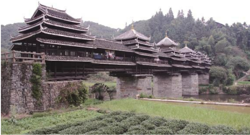
广西三江程阳八寨风雨桥
