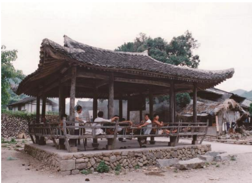
浙江楠溪江东皋村渔亭近景
