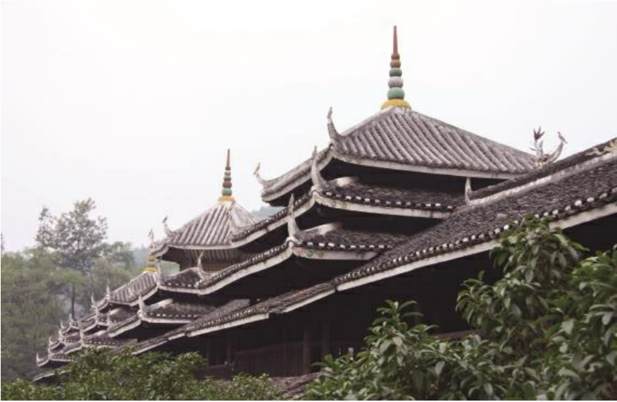
广西三江程阳八寨风雨桥近景
