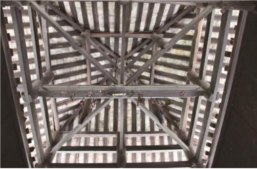
广西三江程阳八寨风雨桥屋顶内部结构
